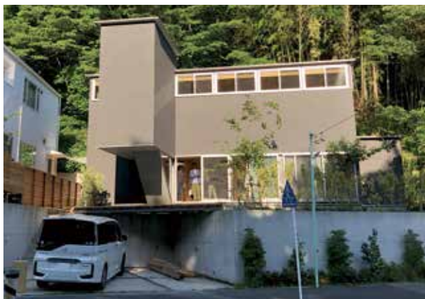
「二階堂の家」外観 前にぶら下がっているのは階段室
