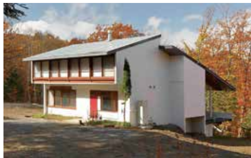
1期工事の姿に減築した外観写真
