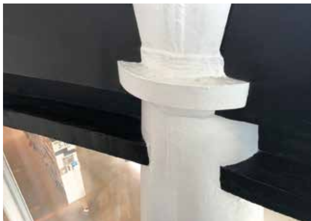
「せんだいメディアテーク」チューブの接合部 黒がプレート、白がチューブ
