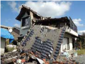
益城町の被災した木造住宅 (2016年10月17日撮影)
