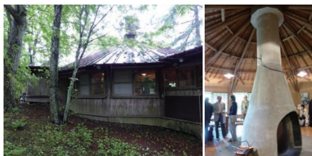
旧レーモンド軽井沢新アトリエ、外観と暖炉のある内部
