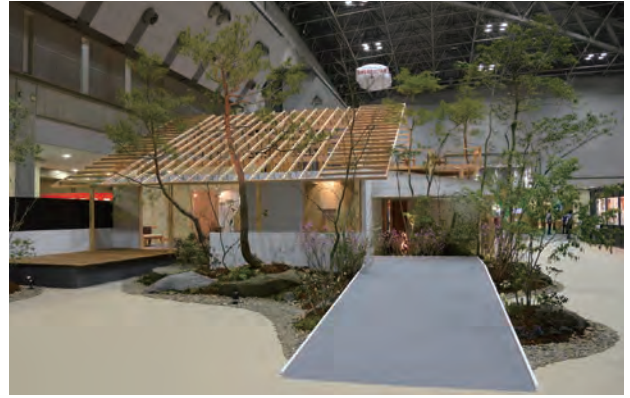
第35回ジャパン建材フェア 高岡の家軸組展示（設計：伊礼智、施工：田中工務店、造園：荻野寿也景観設計）
