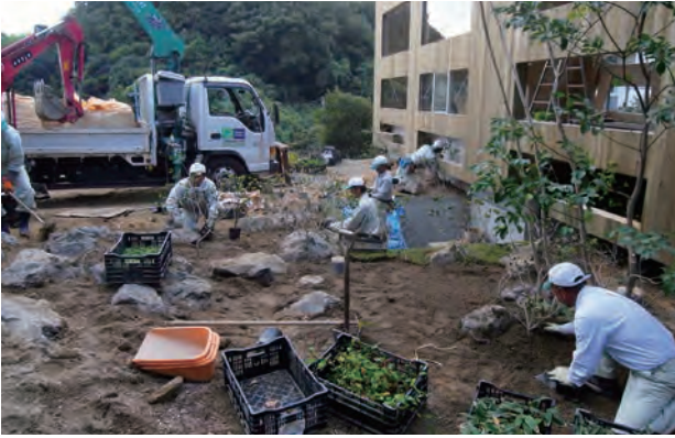
造園工事の様子
