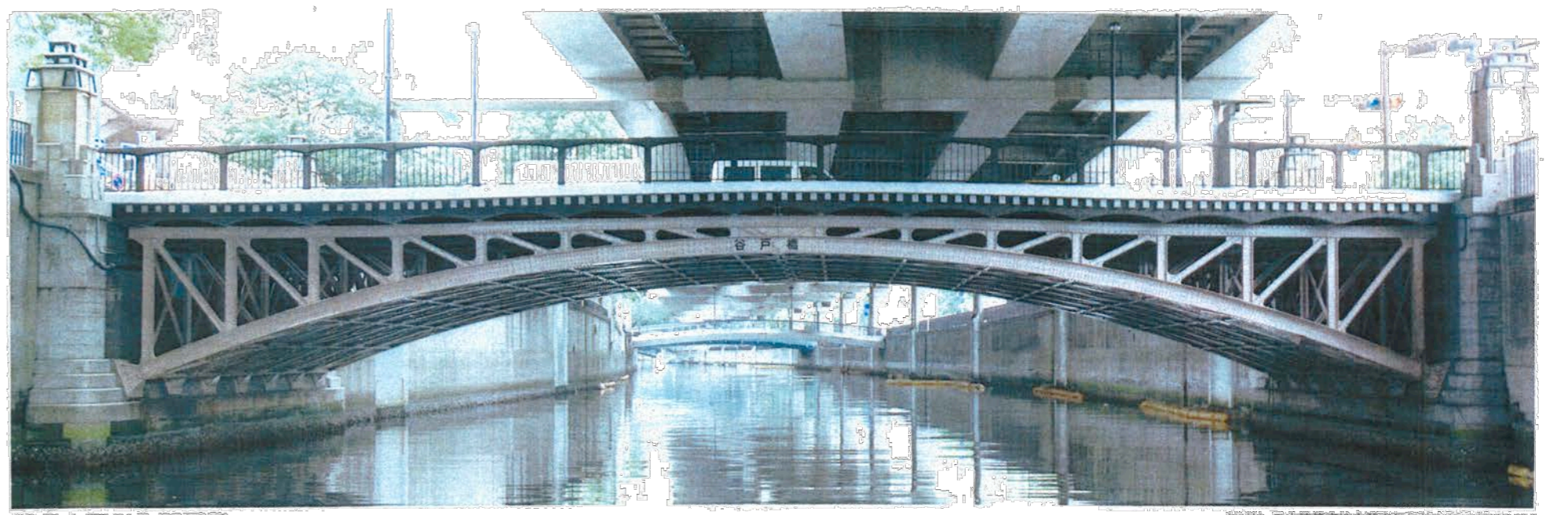
関東大震災復興橋梁
