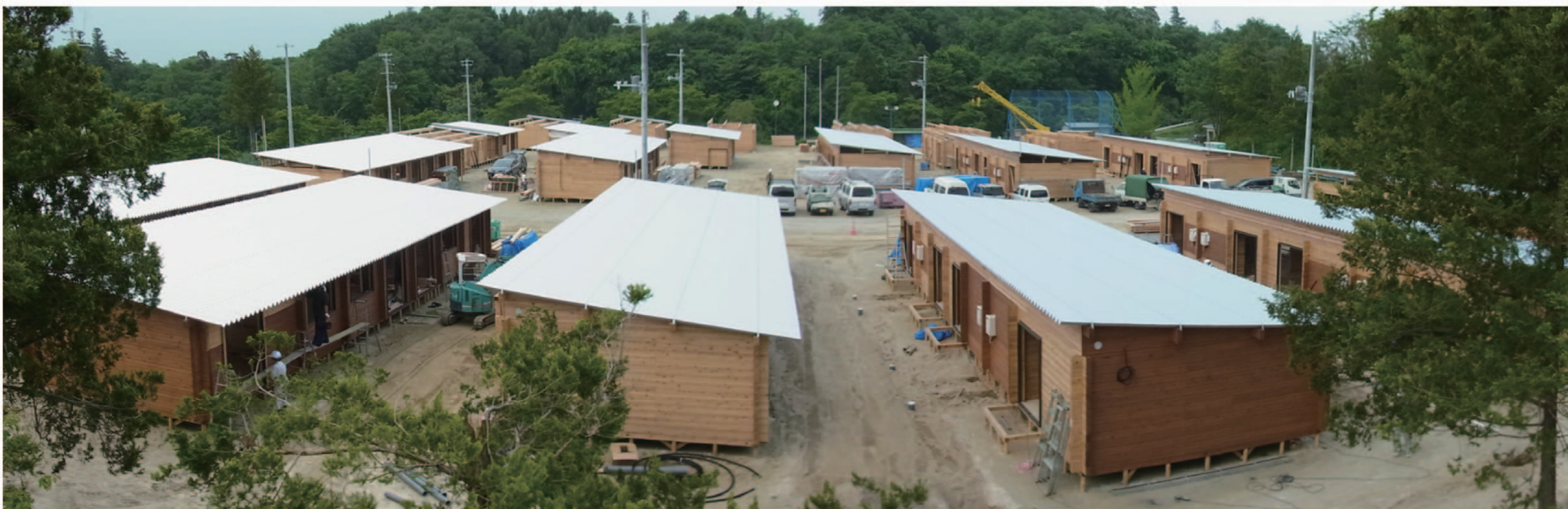
建設中の仮設住宅群（二本松大平農村広場）
