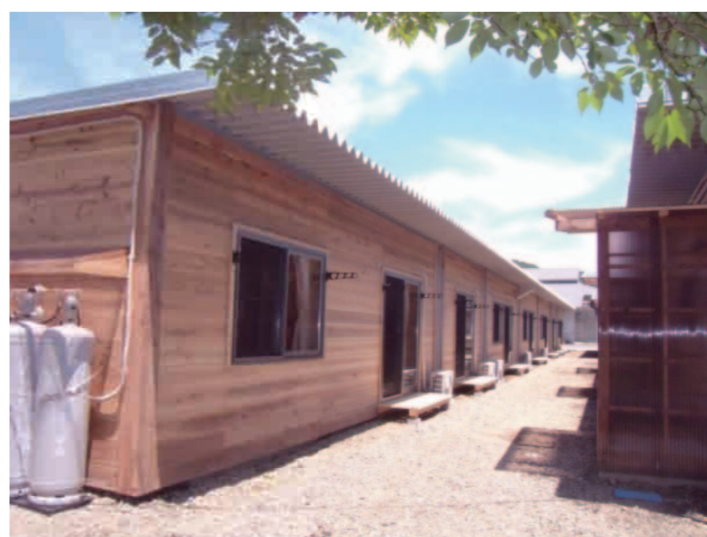
通路を通して見た仮設住宅群
