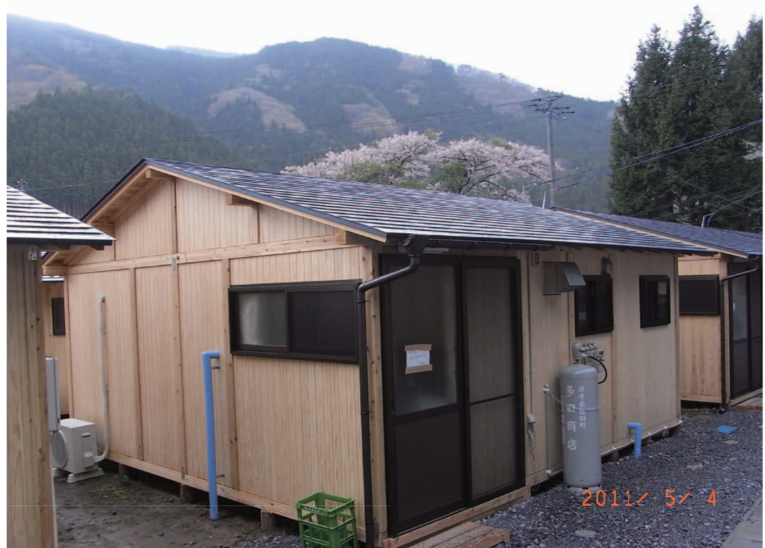
仮設住宅の外観
