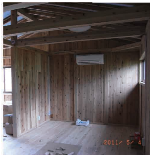
仮設住宅の室内
