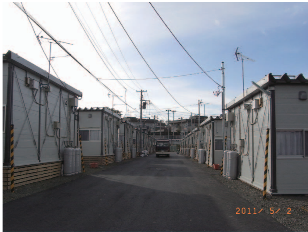
同名取市仮設住宅団地
