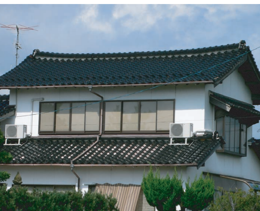
民家の屋根の棟
