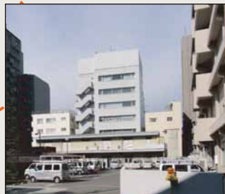
同じ場所 2012年 (NTT 通用門) 巢鴨で最初のSRC造31mの高層ビル電電公社局舎が建設され増築スペースとして残された駐車場。その後民営化され今はNTT 東日本。
