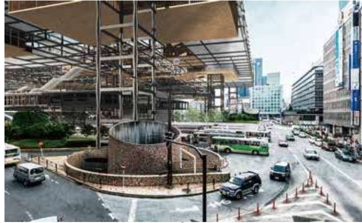
■西口 交通機能が立体的に交差する広場に大きな屋根が覆いかぶり街が活気づく。
