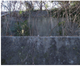
高さ4.2mの擁壁によって上の空き地は閉ざされている。
