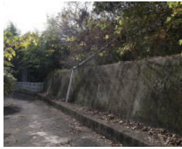
擁壁上の植物が遠くに向かって生えている。
