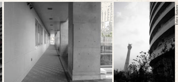
殺風景な共用廊下。住民の姿は殆ど見られない。
