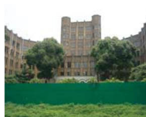
図5: 既存建築物(衛生院正面)
