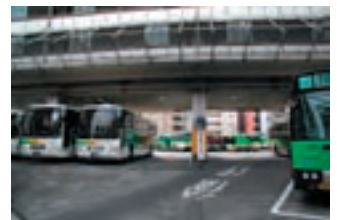
写真3 ピロティ下バス車庫
