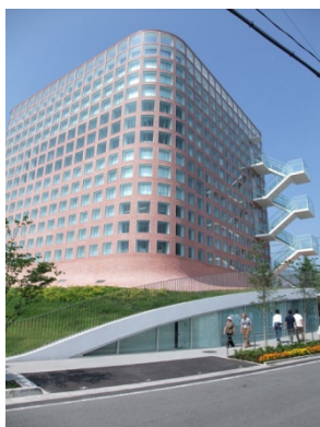
福生市役所 第1棟南外観
