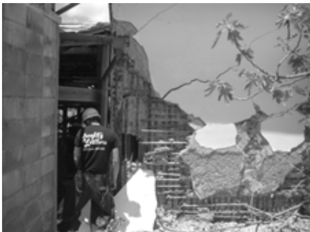
応急危険度判定作業
