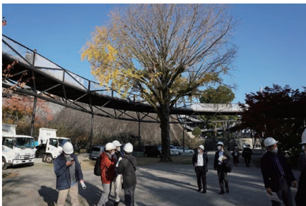
仮設の空中歩道、熊本城特別見学通路
