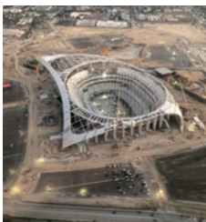
建設中のSo-Fiスタジアムを機内より撮影(2019年10月)
