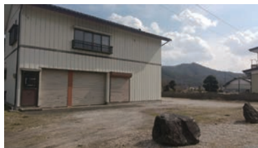
蒸留所に再生予定の 鉄骨造2階建ての空き家
