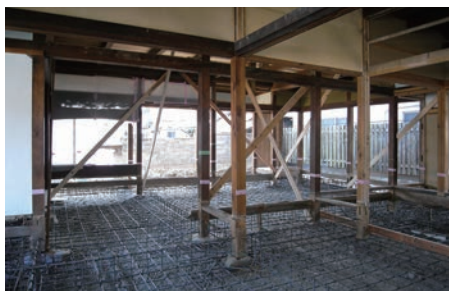
軸組があらわになった「えんがわオフィス」施工中の様子
