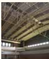
「理工スポーツホール」(1985)
