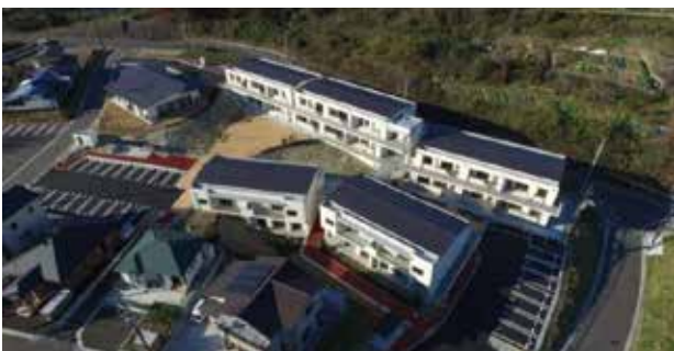
東日本大震災 七ヶ浜町代々崎浜地区災害公営住宅
