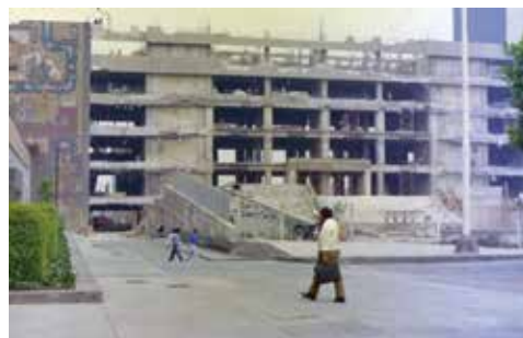
写真2 補強工事中の通信運輸省 (1988年撮影)
