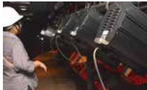
舞台後方の照明室
