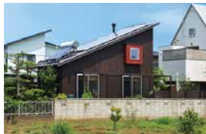
えねこや六曜舎の東側外観と、屋根上の太陽光発電パネルと太陽熱温水器
