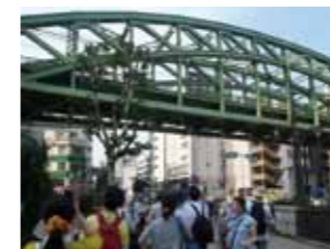
松竹町架道橋
